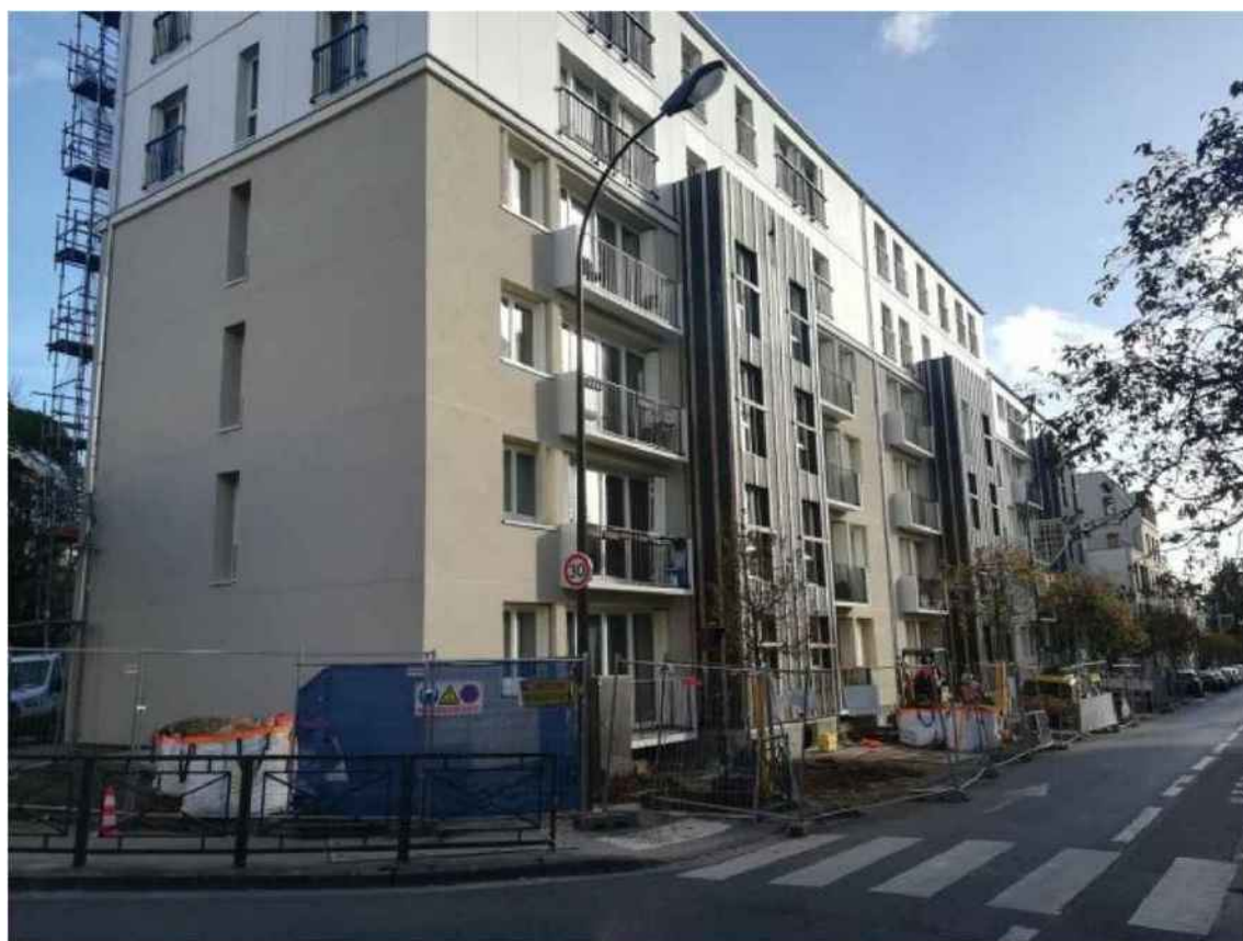
Isolation thermique par l'extérieur © F.L. pour Batiactu
