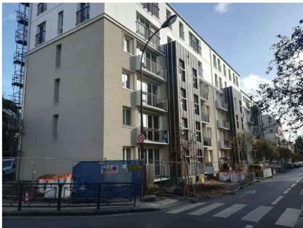
Isolation thermique par l'extérieur © F.L. pour Batiactu
