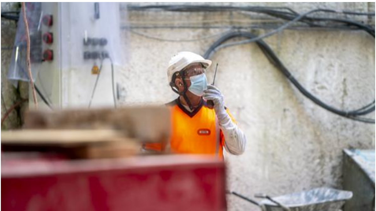
Sur un chantier du Grand Paris express. © Jgp
