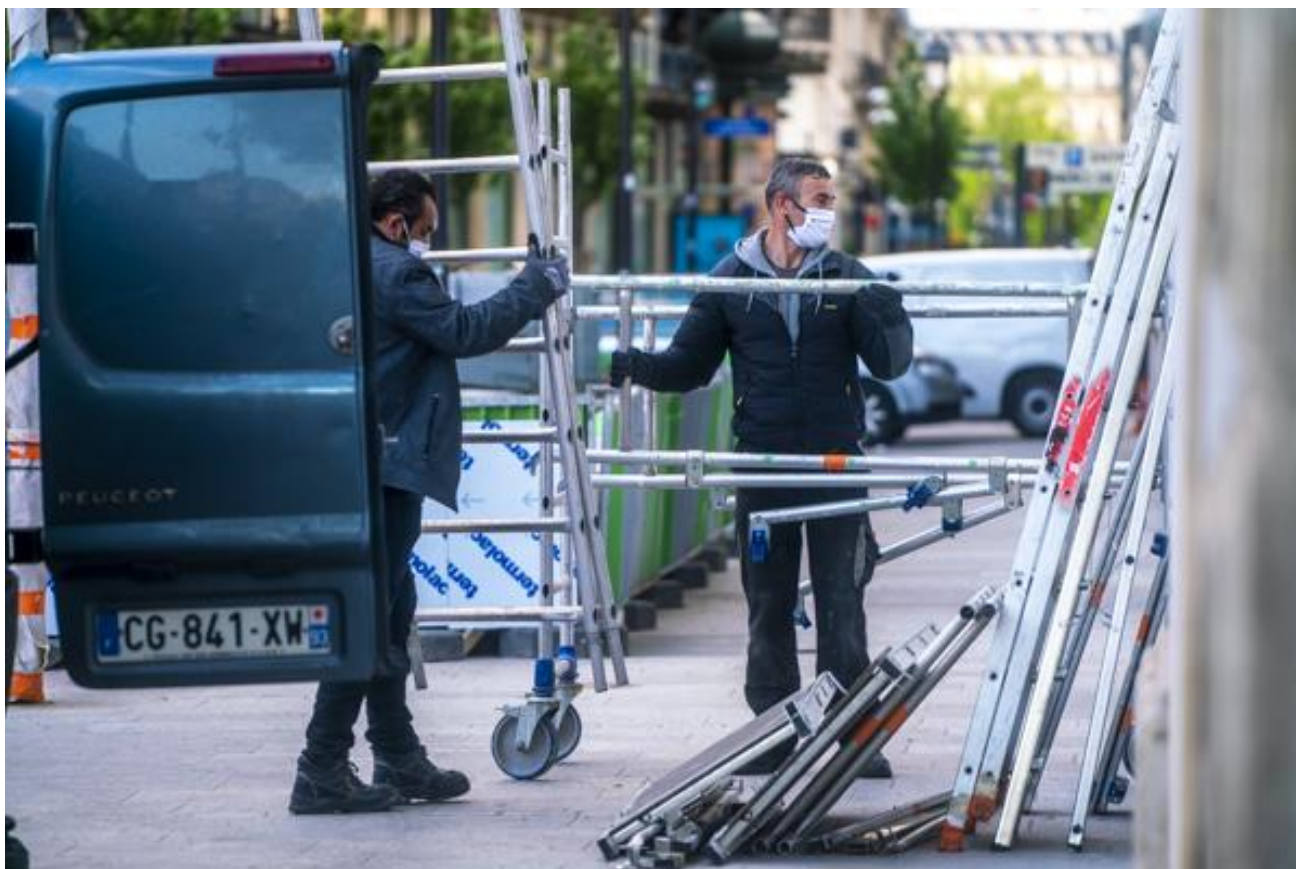
Chantier parisien. © Jgp
