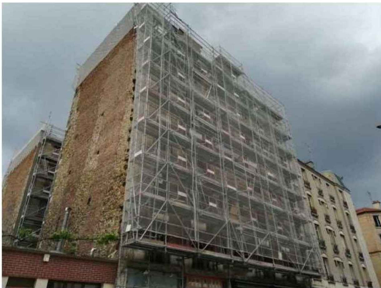
Rénovation logements copropriété © F.L. pour Batiactu
